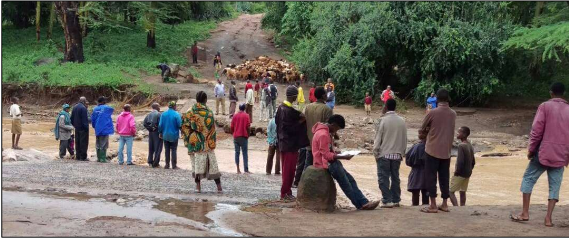
Overvloedige regen spoelde de betonnen brug in Endallah weg
